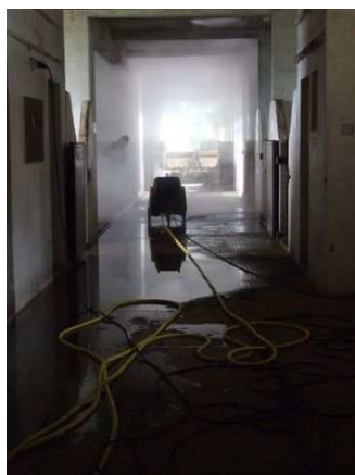
Le nettoyage (ici, à haute pression) puis la désinfection sont des étapes préalables à toute désinsectisation.
